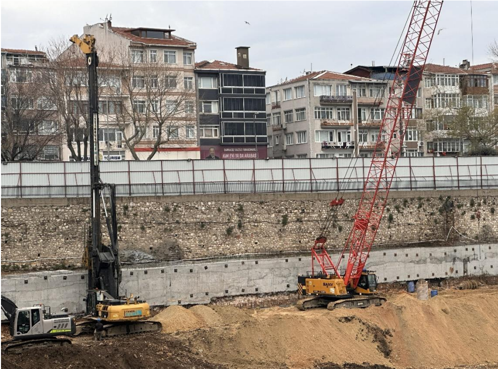
Şekil 2. Aetius Sarnıcı'nda Fevzipaşa Caddesi'ne paralel uzanan tarihi beden duvarına ankrajlanan yeni betonarme istinat duvarı
