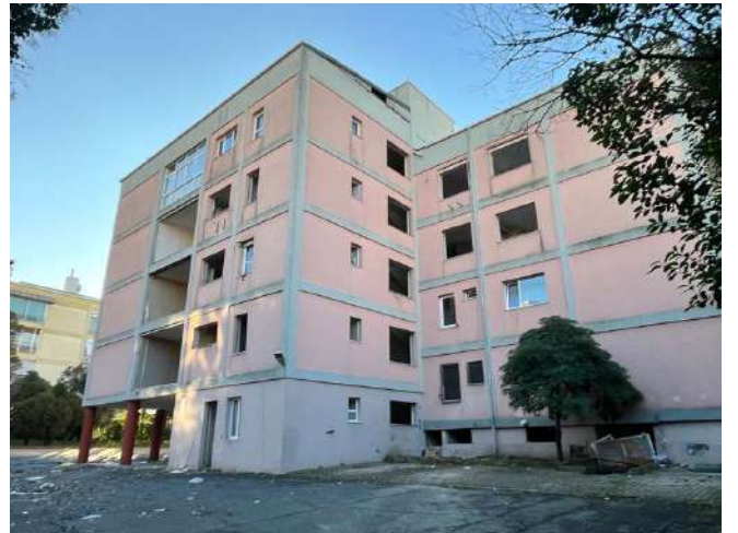
Yıkılmak üzere sökülmekte olan Ataköy I. Kısım B5 Blok (Fotoğraf: H. İlke Alatl, Ocak 2026)
